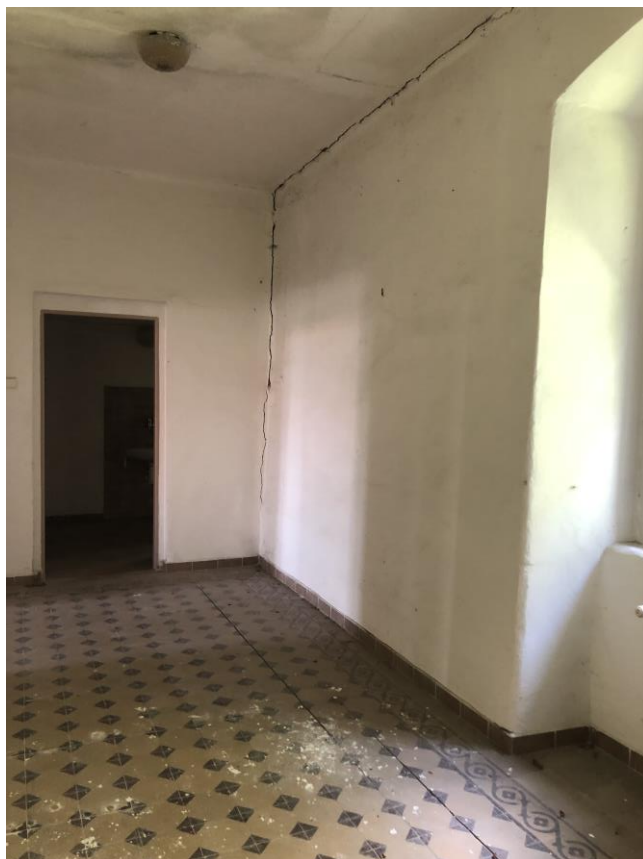
Obr. 6 odtržení původní obvodové stěny – trhliny v napojení příčky, podhledu a v dlažbě
