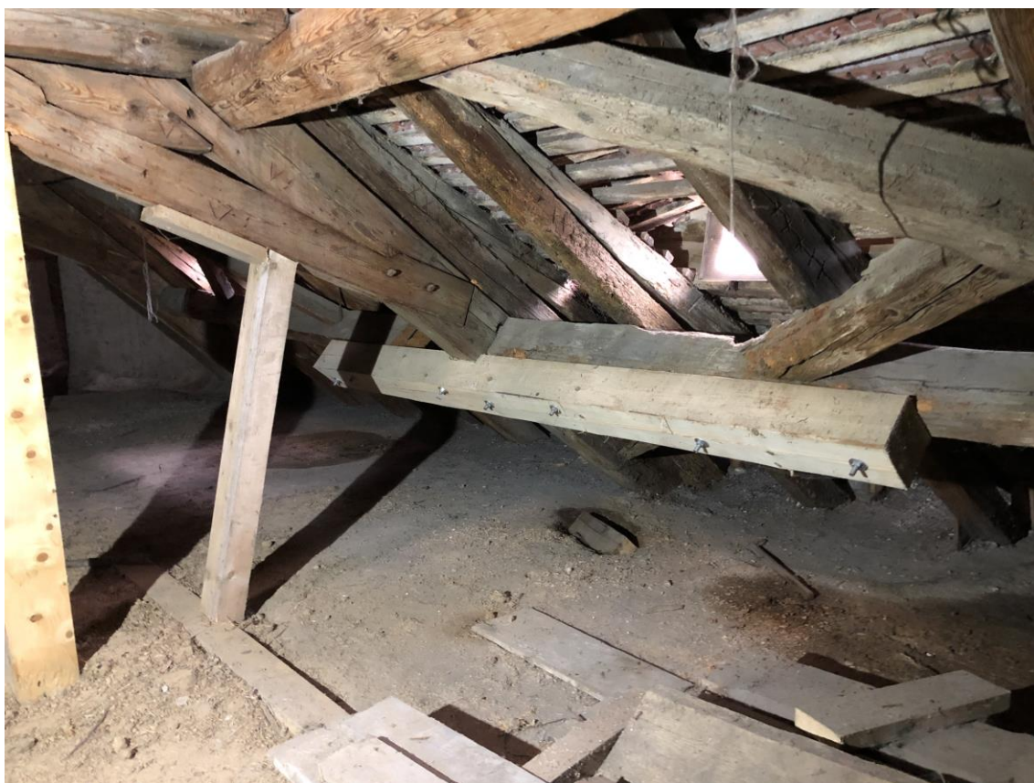
Obr. 2 dodatečné podepření plné vazby a zesílení spodní vaznice
