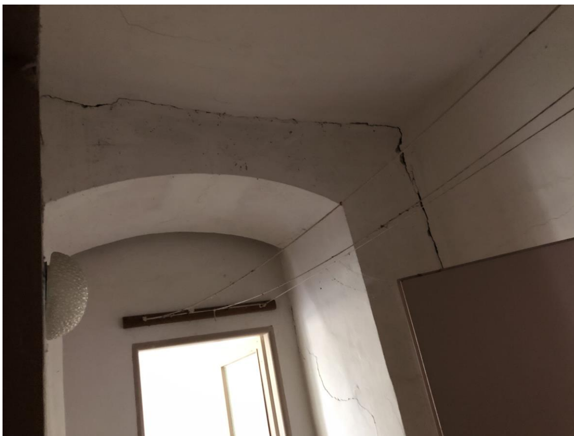
Obr. 5 odtržení původní obvodové stěny – trhliny v napojení příčky
