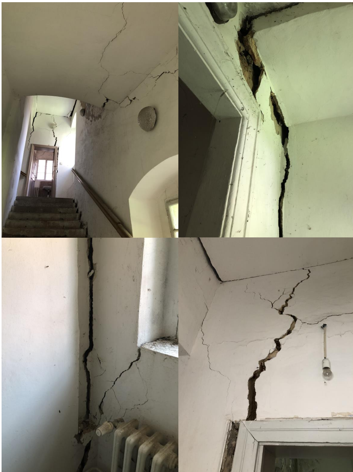
Obr. 8 trhliny ve stěnách v přístavbě
