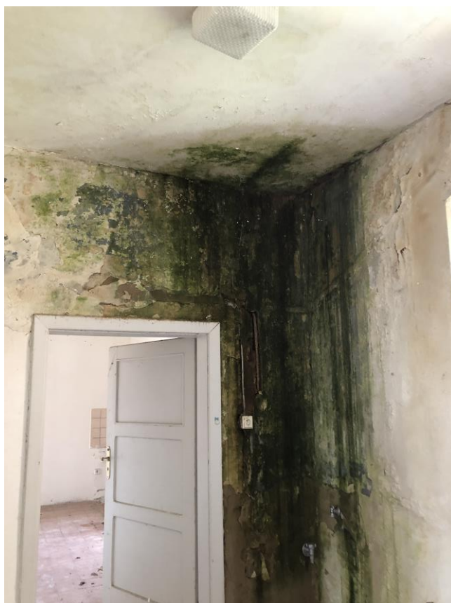
Obr. 7 degradace omítky vlivem zatékání
