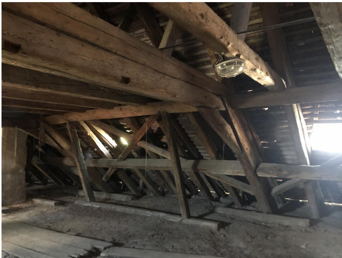
Obr. 1 dodatečné podepření vaznice
