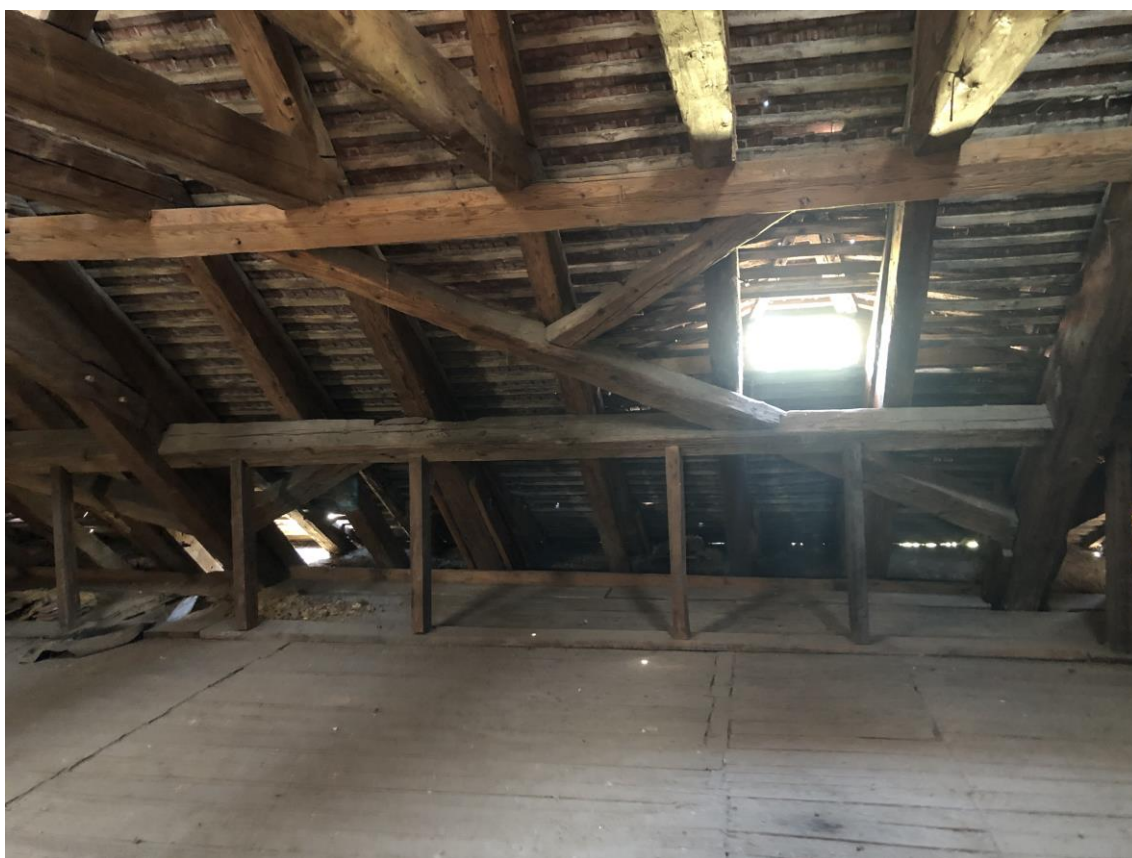
Obr. 3 dodatečné podepření spodní vaznice
