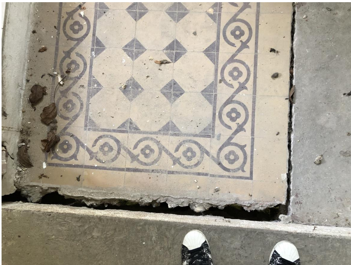
Obr. 9 odtržení podesty schodiště v přístavbě od původní obvodové stěny
